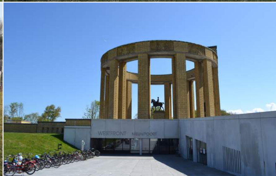
Koning Albert I Monument in Nieuwpoort. (© VLM, 2018)
