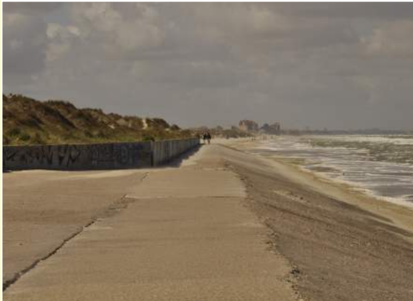
Betonnen zeewering aan de voet van de Westhoekduinen; op de achtergrond de natuurlijke strand/duinovergang op Frans grondgebied (© VLM, 2018)
