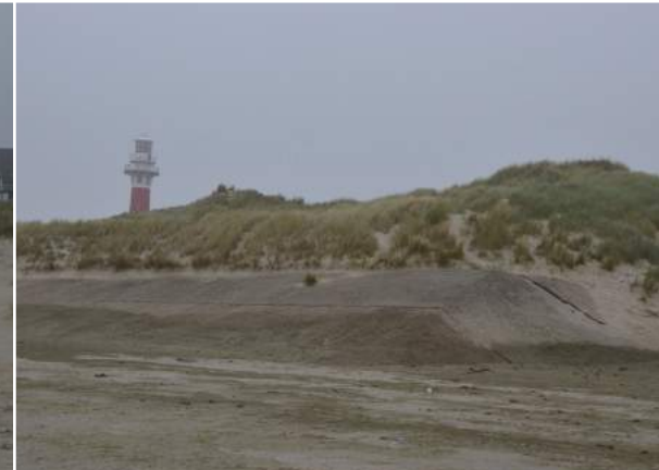
Betonnen zeewering aan de voet van de Sint-Laureinsduinen, restant van de Atlanticwall uit de Tweede Wereldoorlog (© VLM, 2018)
